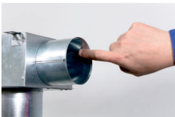
3) Vnitřní povrch vyústku namažeme kluzným přípravkem*.
