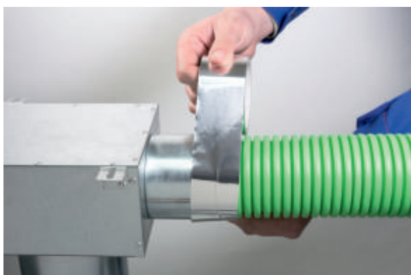
7) Spoj zajistíme vzduchotěsnou lepicí páskou.
